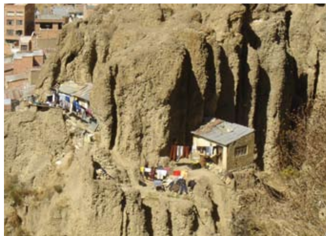
Construcciones precarias en las laderas de la Ciudad de La Paz
