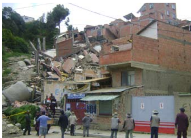
Deslizamiento de viviendas en la zona de Retamani
